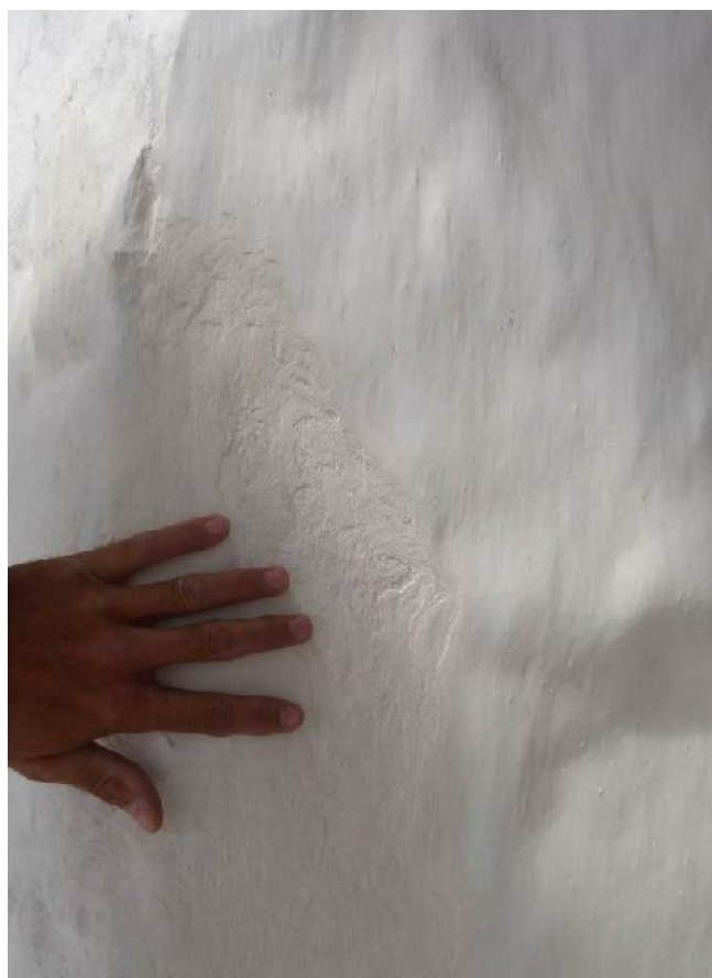
Øverst på facaden og i lugehullerne afrenses kalklagen ikke – sidder godt fast. Kanterne kan stryges et par gange med sandkalk.
