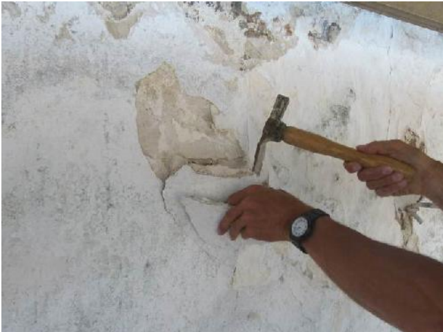
Større cementflade 3-5 mm tyk udenpå ældre lag kalkninger
