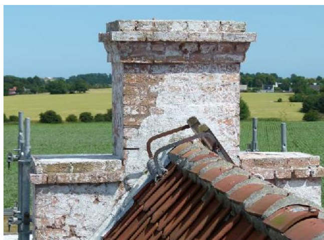
Øverst østre kamtakker. Her lægges afdækning på de afrensede overflade med Lithomex og skråkanter på det udkragedede skifte.
