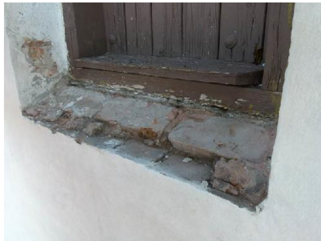
Sålbænk på de øverste små luger. Afrenses for løse sten og mørtel, og der opbygges en afdækning med Lihomex.
