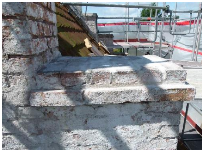
Ommuret skifte på en kamtak. Her bygges en ny afdækning op med Lithomex, og der lægges en skråkant på det udkragede skifte.
