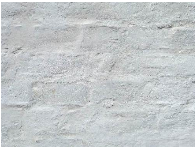
Murværk med mursten.
