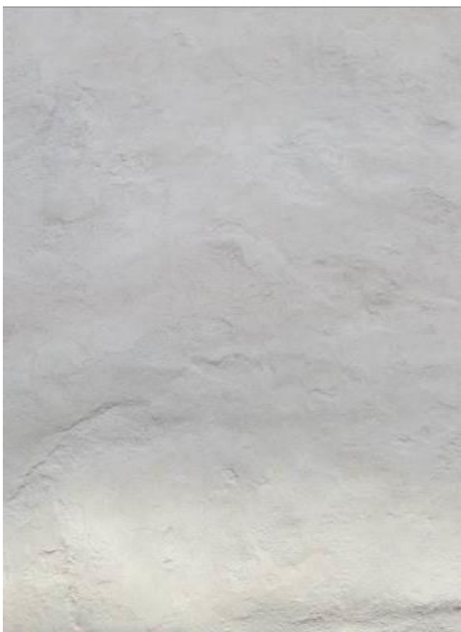
Sandkalket overflade på ujævn overflade og med rester af gamle kalklag. Sandkalken fæstner og udjævner overgange i kalklagene.
