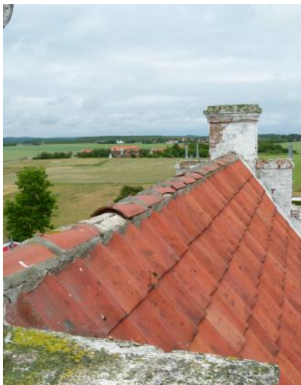
Skader på taget rygning og blyinddækninger – løse, revnede og lappede.
