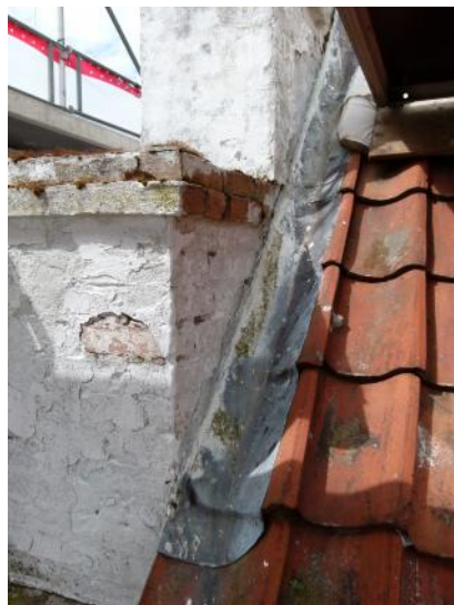
Skader på taget rygning og blyinddækninger – løse, revnede og lappede.
