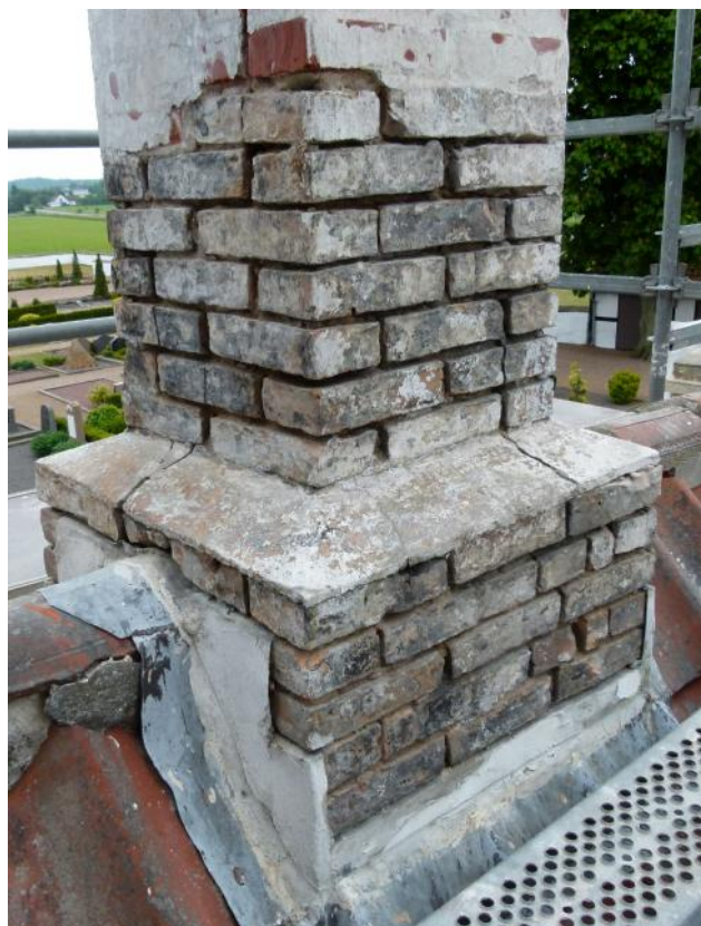
Den nederst del er den gamle skorsten med ny påmuring af røde sten.
