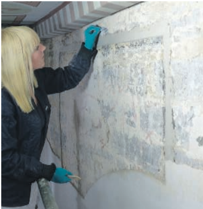
Rammer af mørtel. Frida Hulten i arbejde med et stykke rankeslyng i koret. Foto: Niels-Holger Larsen
